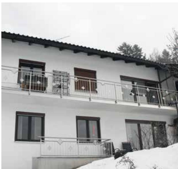
イラストに示されているのはステンレスで製造されているシングル家族用の長さ11mバルコニーの柵です。
